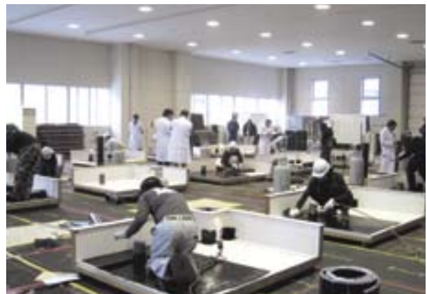
防水施工（改質アスファルトシートトーチ工法防水工事作業）
